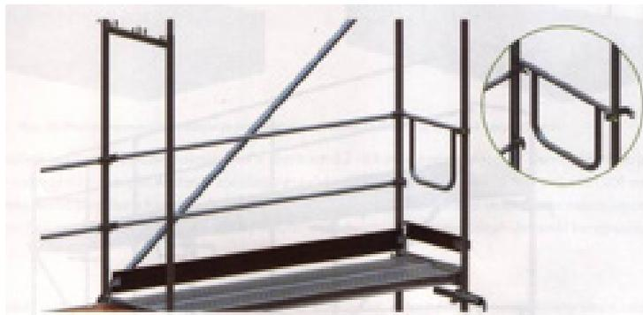
**12** Pose des planchers et de plinthes et amarrage des cadres.
